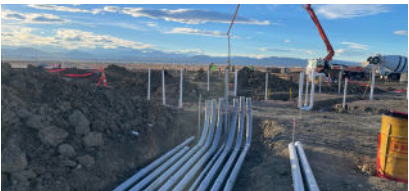
Underslab conduit installation
